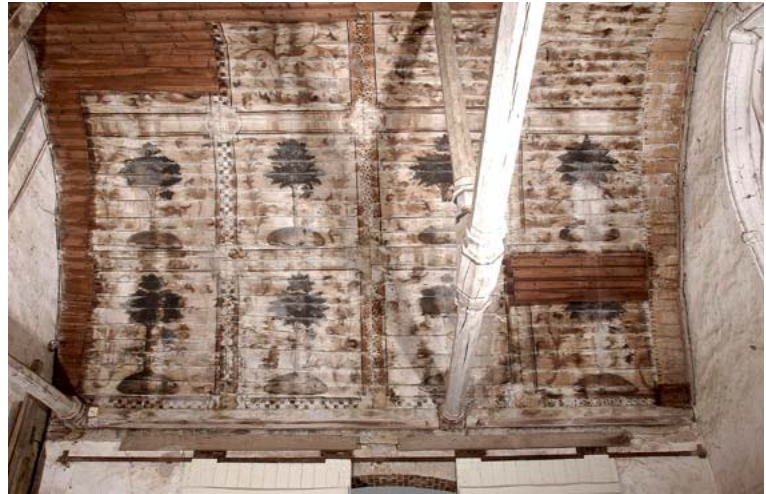
Fig. 13 : Durtal, chapelle du manoir de Château-Bosset, voûte : arbres portant des écus.
