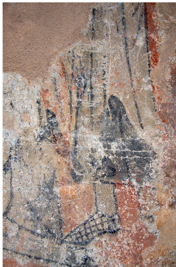
Abb. 6. Chorostwand, Leibungsfläche Nord, Detail mit Schäden (© Susanne Keller, März, 2019).
