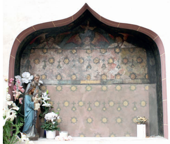
Fig. 6. Strasbourg (67), église Sainte-Madeleine, ancien chœur, mur sud, deuxième travée : trois anges tenant une draperie (© Camille Jouen, 2017).
