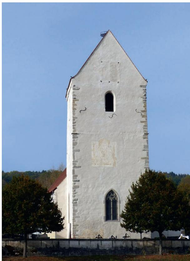
Fig. 8. Oltingue (68), église Saint-Martin, clocher, côté est : vestiges du cadran d'horloge et de la bretèche (© Jean-Luc Isner, 2019).
