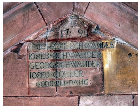
Abb. 5. Freiburger Münster, Michaelsempore, Südwand, Datierung zur dritten Überarbeitung der Wandflächen 1794 (© Alexander Ehrath, 2011).
