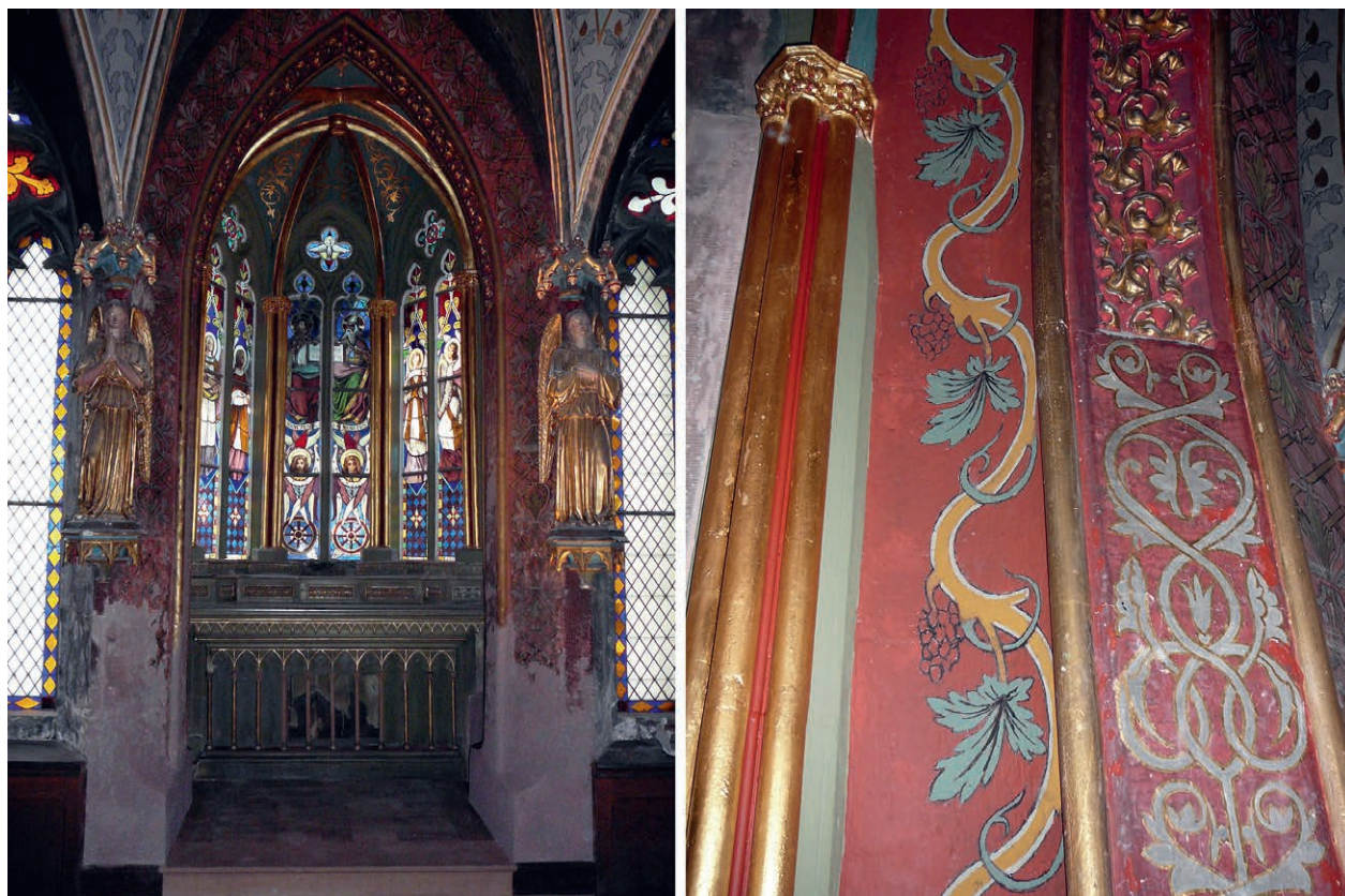
Fig. 1. Guebwiller (68), ancien couvent des Dominicains, chapelle néogothique. Les peintures murales aux motifs floraux répétitifs étaient dans un tel état de dégradation suite à des décennies d'infiltrations que le parti d'intervention – une fois les conditions d'étanchéité rétablies – a été de les refaire à neuf à partir des vestiges encore lisibles. Cela relevait de l'impérieuse nécessité de rétablir ce qui pouvait l'être de sorte à transmettre le bien dans les meilleures conditions possibles de préservation. (© Atelier d'Architecture R. Duplat, juin 2008).
