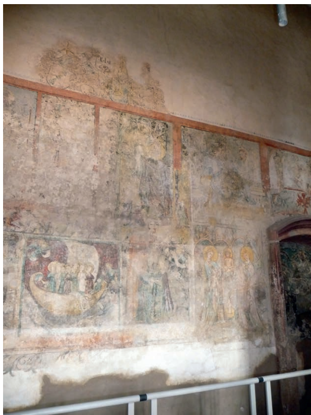
Fig. 2. Guebwiller (68), ancien couvent des Dominicains, bas-côté nord de la nef. Toute la difficulté est de donner à lire des décors mis au jour avec plusieurs périodes identifiées, où le compartimentage apporté par les cadres de scènes permet de soulager la lecture (© Atelier d'Architecture R. Duplat, novembre 2010).
