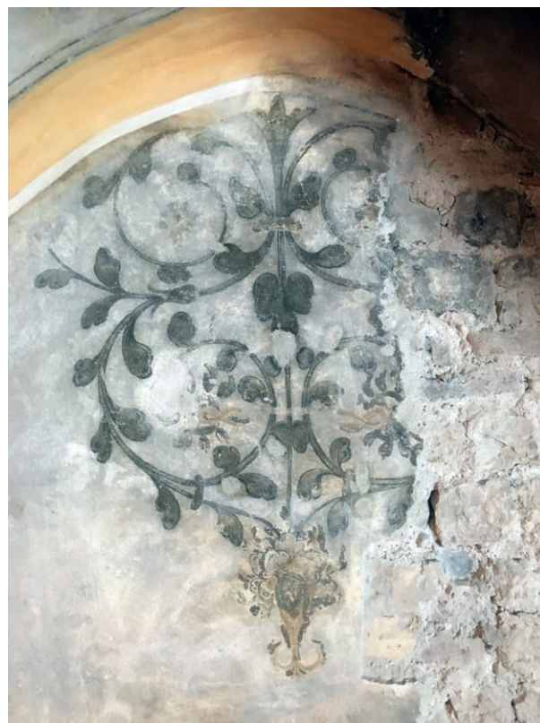
Fig. 5. Ottmarsheim (68), église Saint-Pierre et Saint-Paul, chapelle des Chanoinesses. Vestiges des décors mis au jour après démolition d'une cloison rapportée (© Atelier d'Architecture R. Duplat, octobre 2017).
