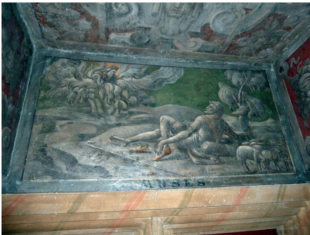
Fig. 3. Colmar (68), maison Pfister, détail des scènes animant la façade. Le travail de restauration s'est limité à nettoyer la couche picturale, tout en réduisant le voile donné par l'application de vernis antérieurs inadaptés (© Atelier d'Architecture R. Duplat, novembre 2012).
