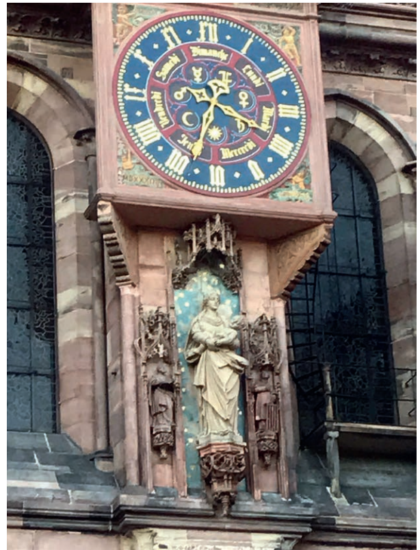
Fig. 7. Strasbourg (67), cathédrale, transept sud, Vierge à l'enfant du deuxième niveau après restauration (© Pierre-Yves Caillault, 2021).
