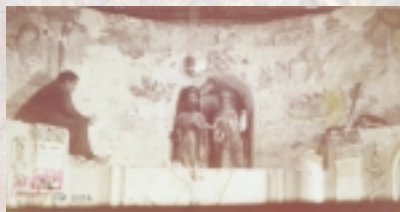
Saint-Jacques-des-Guérets, chantier de dégagement des peintures en septembre 1891 (cl. ENSBA)
