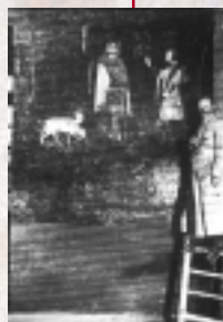
Louis Yperman au Palais des Papes, chantier de la Chambre du Cerf, avant surpeints, 1907
